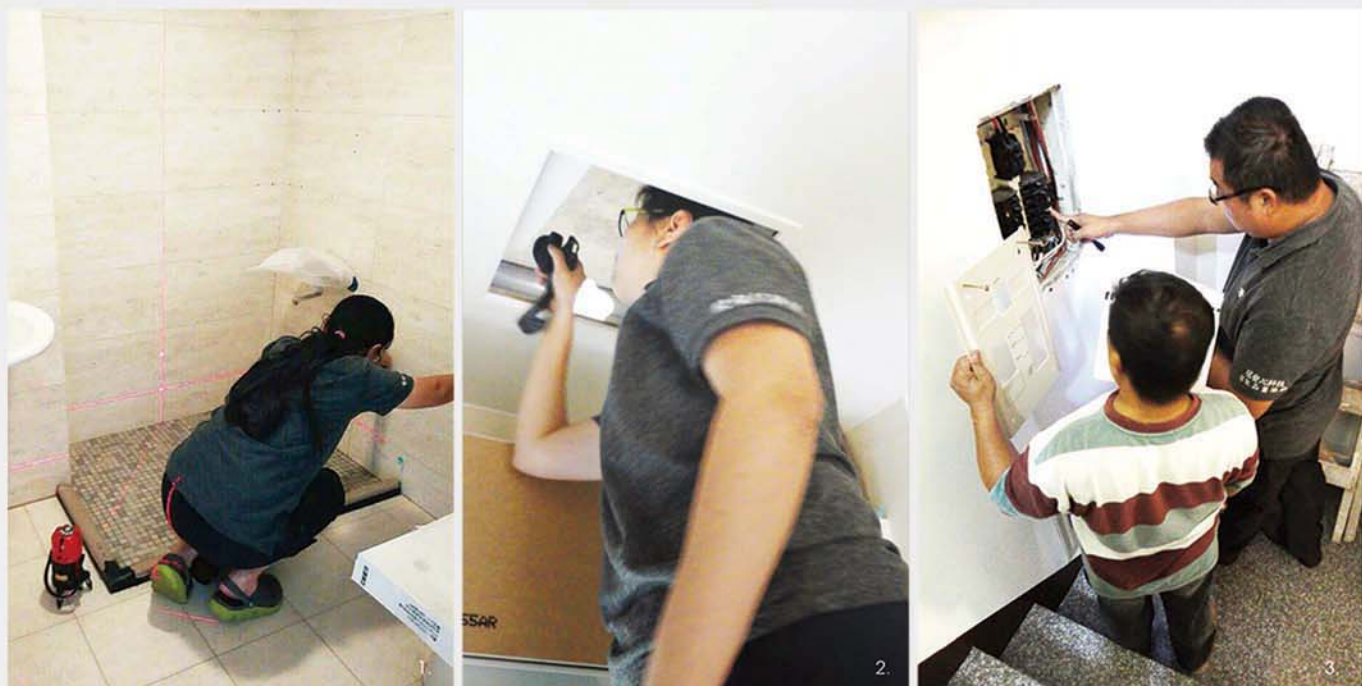
1.2.3. 檢驗房屋必須測量地板水平和洩水坡度，檢查管道間，以及配電箱等。
